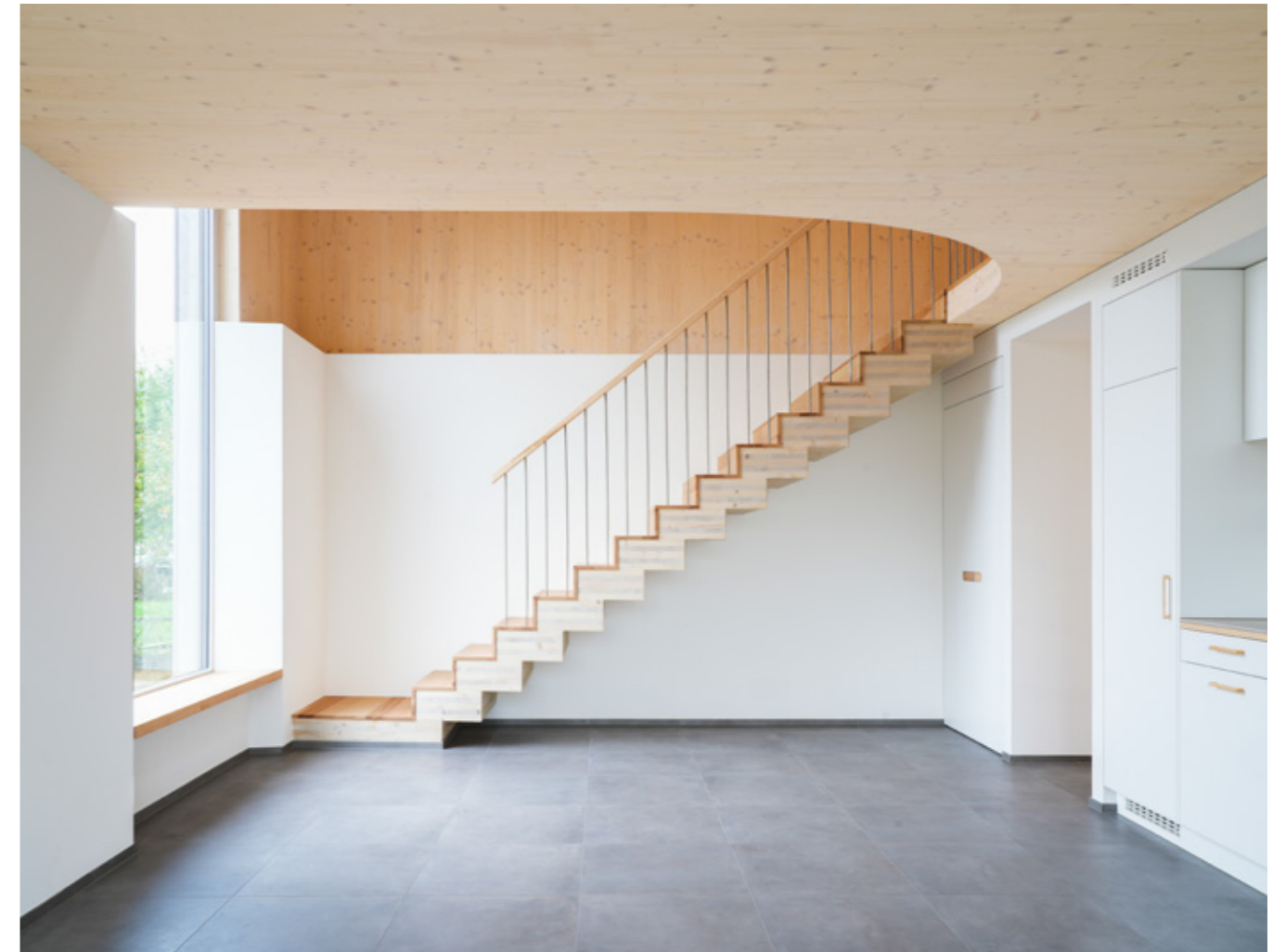
Objekt Umbau Einfamilienhaus, Zofingen Architektur atak.gmbh, Zofingen Treppe Unterkonstruktion Brettsper Holzplatte Treppenstufen Esche massiv, geölt
