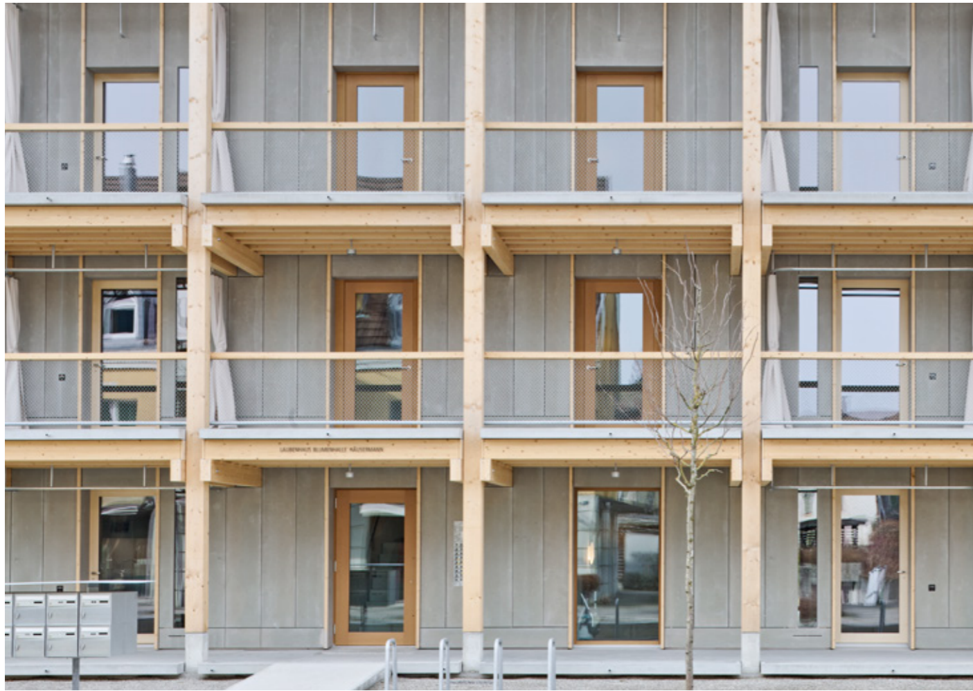
Objekt Neubau Mehrfamilienhaus, Langenthal Architektur rolf mühlethaler architekten, Bern Ausstentüren Rahmentüren, Fichte massiv/Eiche massiv
