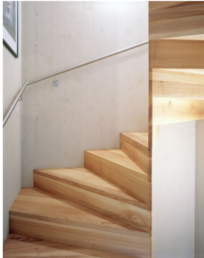
Objekt Neubau Mehrfamilienhaus, Corminboeuf Architektur LVPH architectes, Fribourg Treppe Esche massiv, geölt Wange DSP, UV-Schutz weiss
