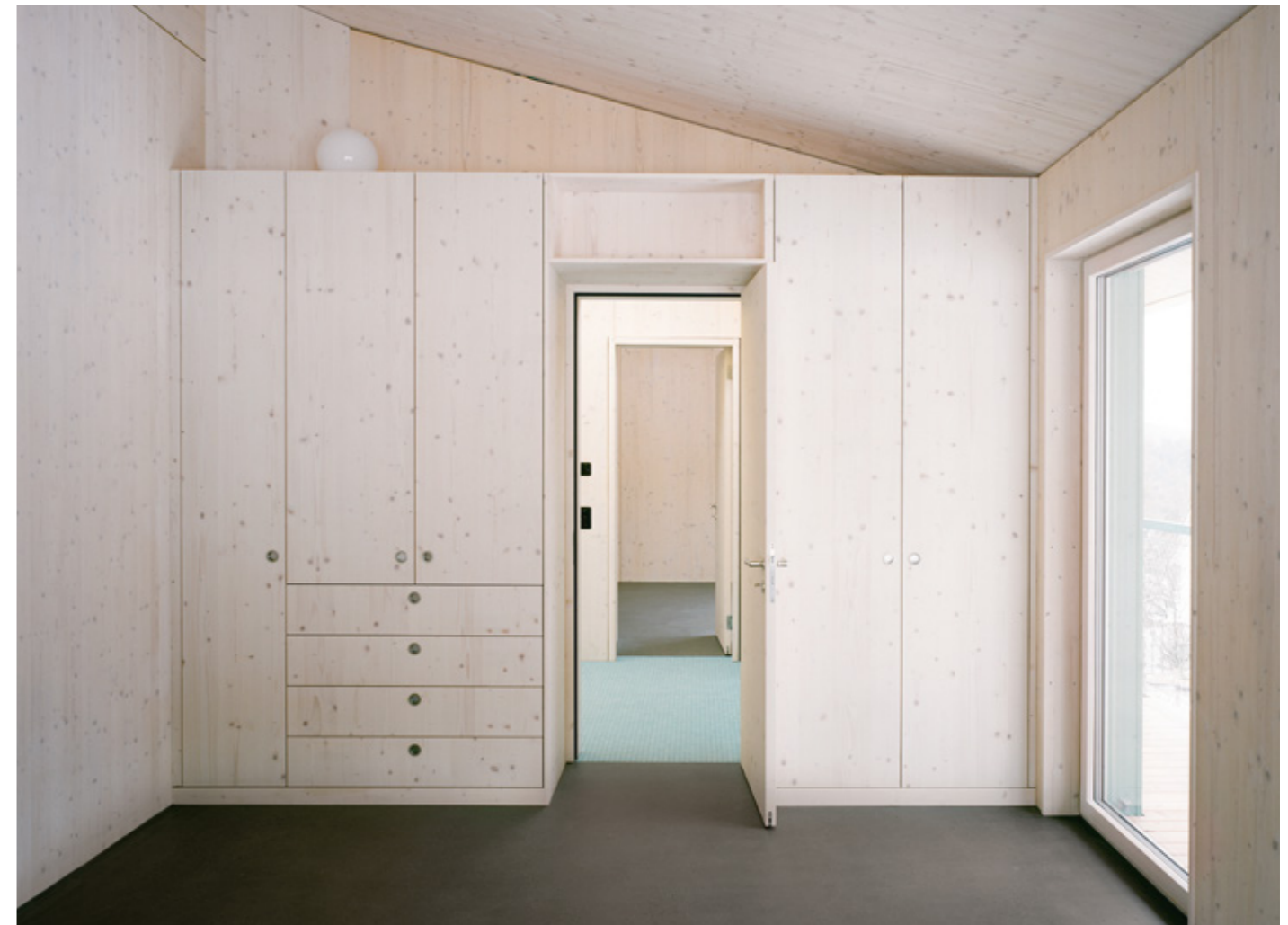
Objekt Neubau Einfamilienhaus, Burg im Leimental Architektur amreiniger architekten, Basel Schränkfronten Spanplatte, Fichte/ Tanne (astig) furniert mit Umleimer, UV-lasiert, weiss pigmentiert Griffe Muschelgriffe
