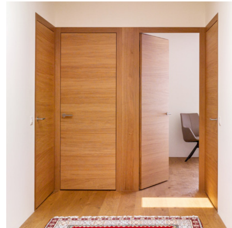
Objekt Neubau Einfamilienhaus, Meggen Architektur geisser + luedi, Zürich Türblätter Vollspanrohrling, Eiche furniert, quer, lackiert Rahmen Eiche massiv/ Eiche furniert, lackiert Griff Edelstahl
