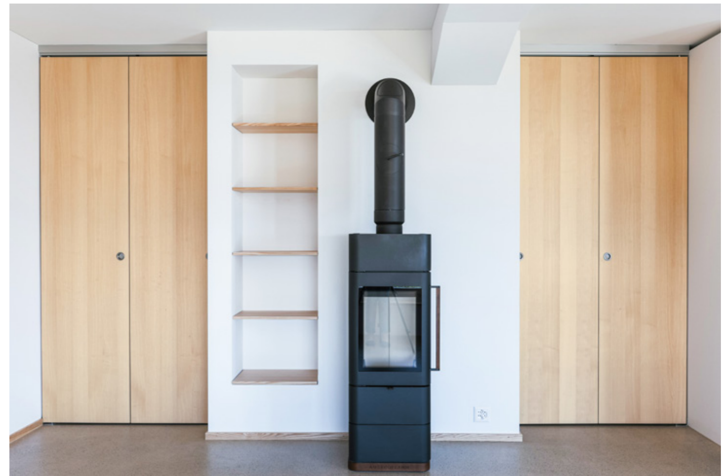
Objekt Umbau Mehrfamilienhaus, Forch Architektur Atelier Équilibre, Zürich Faltschiebetüren Esche, furniert, lackiert mit Roheffektlack Tablare Esche massiv
