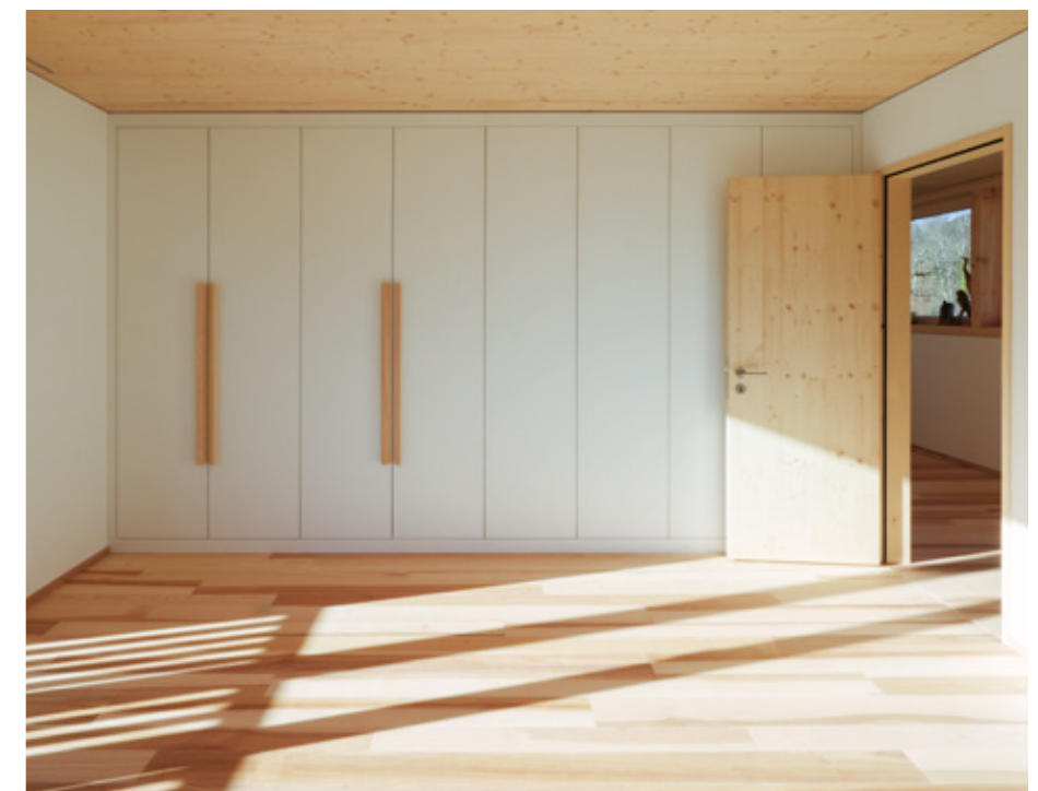
Objekt Neubau Einfamilienhaus, Lauwil Architektur atak.gmbh, Zofingen Schränkfronten Spanplatte, weiss beschichtet Griffe Esche massiv, geölt
