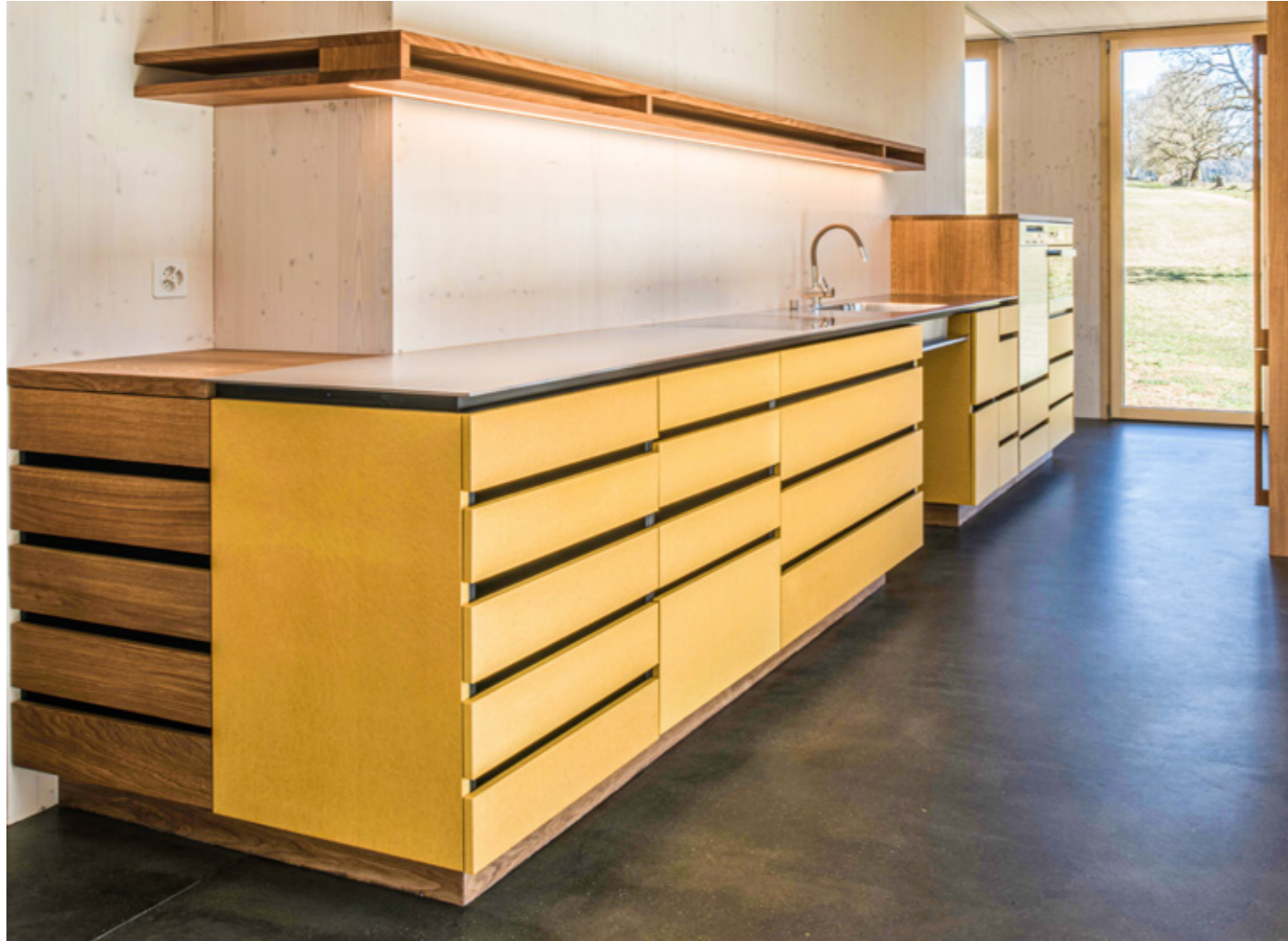
Objekt Neubau Einfamilienhaus, Epauvillers Architektur Daniel Widmer Küchenfronten MDF Valchromat, gelb, lackiert mit Roheffektlack/ Eiche massiv, geölt Abdeckung Franke PureSteel Tablar Eiche massiv, geölt/ integrierte Leuchte
