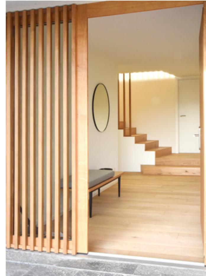
Objekt Umbau Einfamilienhaus, Kaltbach Architektur atak.gmbh, Zofingen Treppe/Staketten Eiche massiv Massivholzboden Eiche massiv
