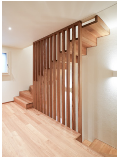
Objekt Umbau Einfamilienhaus, Langenthal Architektur atak.gmbh, Zofingen Treppe/Staketten Eiche massiv
