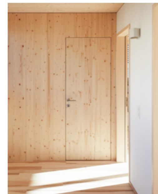
Objekt Neubau Wohnhaus, Lauwil Architektur atak.gmbh, Zofingen Türblatt 5-Schicht-Platte, lackiert mit Roheffektlack Rahmen 3-Schicht-Platte
