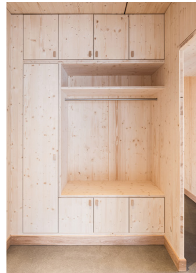
Objekt Neubau Mehrfamilienhaus, Kriens Architektur Cla Büchi, Luzern Schrankfronten, Seiten, Deckel 3-Schicht-Platten Fichte Griffe Esche, Spezialanfertigung schaeerholzbau
