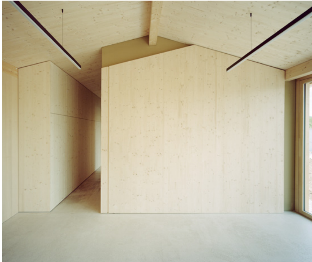
Objekt Neubau Wohn- und Atelierhaus, Stüsslingen Architektur Gautschi Lenzin Schenker Architekten, Aarau Schiebetüre 3-Schicht-Platte Fichte/Tanne, roh
