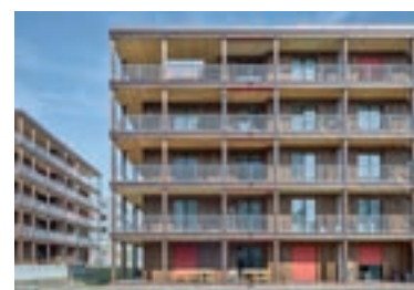
Construction du complexe résidentiel «Schweighof», Kriens
