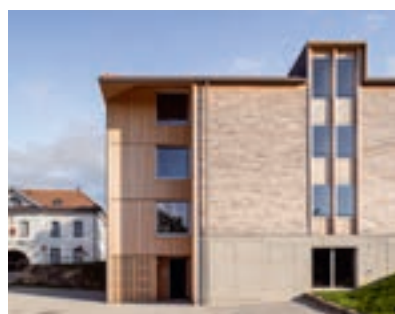
Immeuble collectif, Vaulruz
