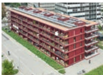
Construction d'un immeuble collectif, Zurich
