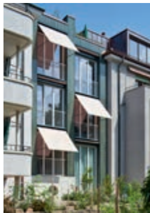
Agrandissement d'un immeuble collectif, Lausanne
