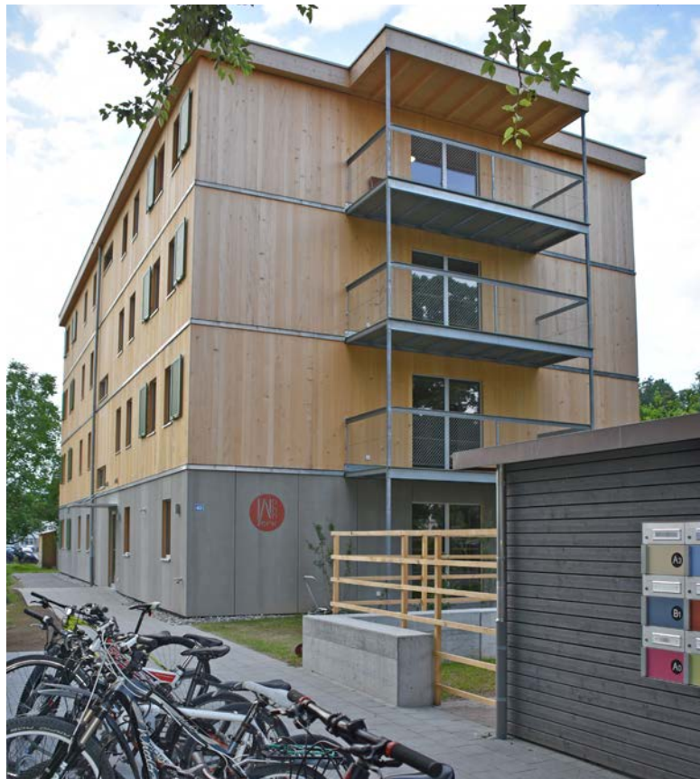
Das WohnWerk ist ein viergeschossiger Holzelementbau mit 52 Betten.
