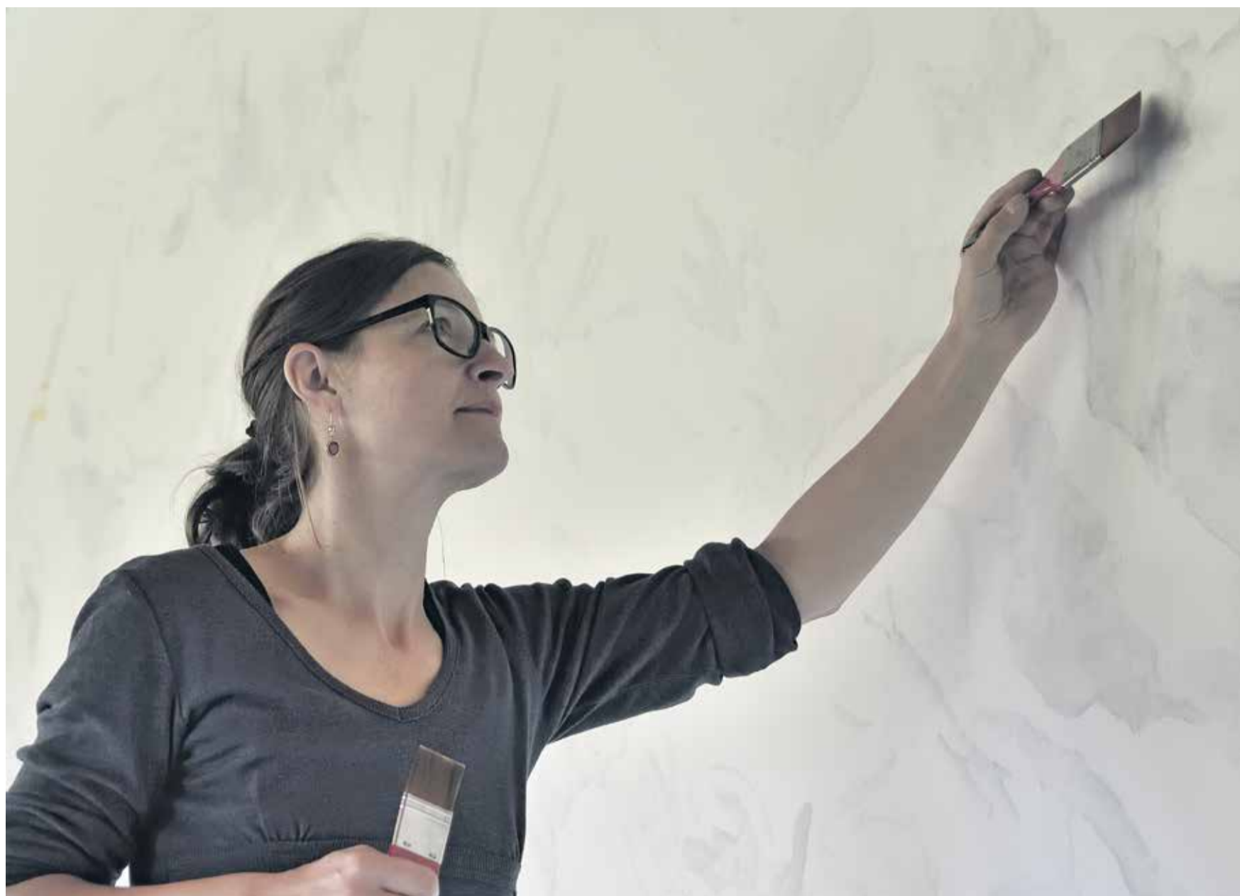
Monika Müller trägt eine Schicht Graphit auf die Wand auf. Foto Doris Hüslar
